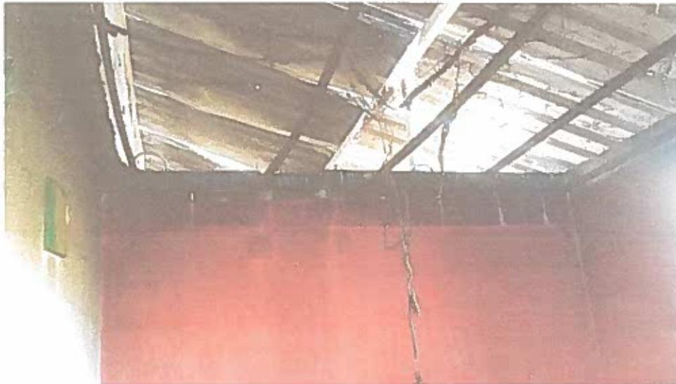
Fiação derretida e telhas deformadas nos apartamentos
