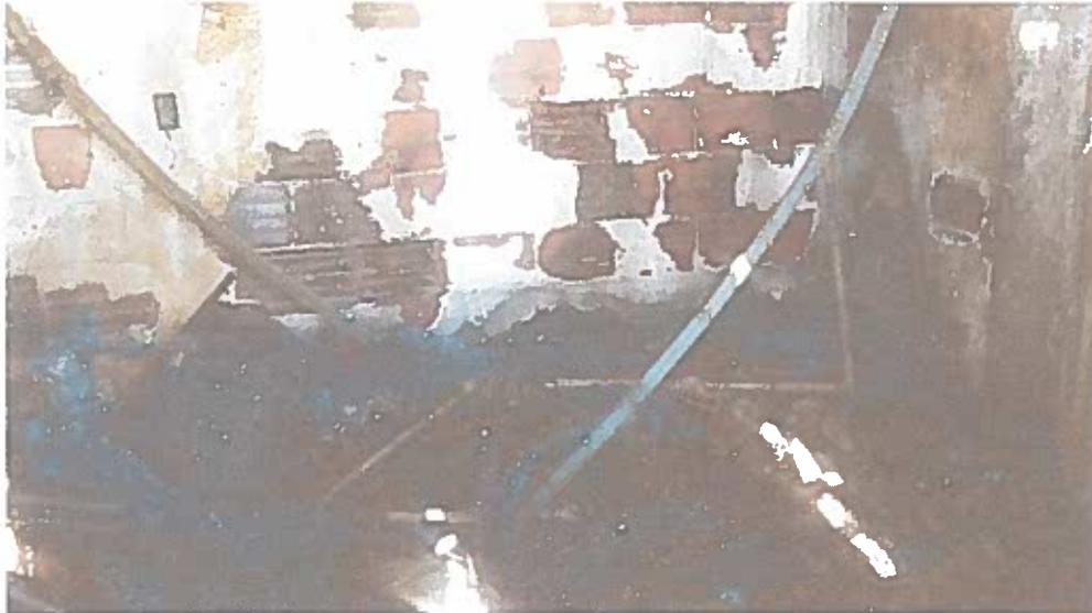
Tubulações de água e caixas de luz deterioradas pelo calor
